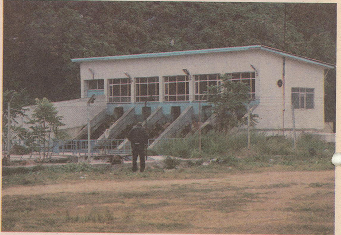
Proje gerçekleştirilirse, Kadıköy Moda'da bulunan Atıksu Arıtma ve Deniz Deşarjı Tesisi, yeşil alan üzerinde genişletilerek büyük bir tesis haline getirilecek.
